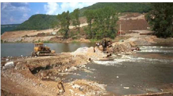
Строительство Юмагузинского водохранилища в национальном парке «Башкирия».
