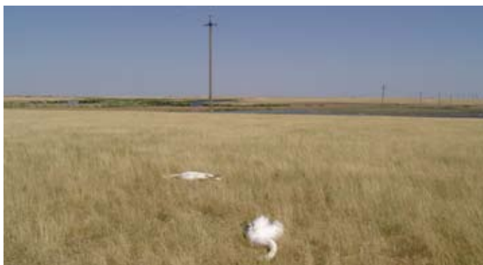
Местами преобладает гибель птиц от столкновения с проводами и опорами ЛЭП.
